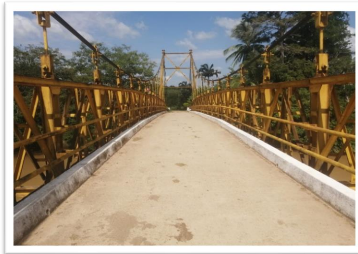
Puente de La Chapa
