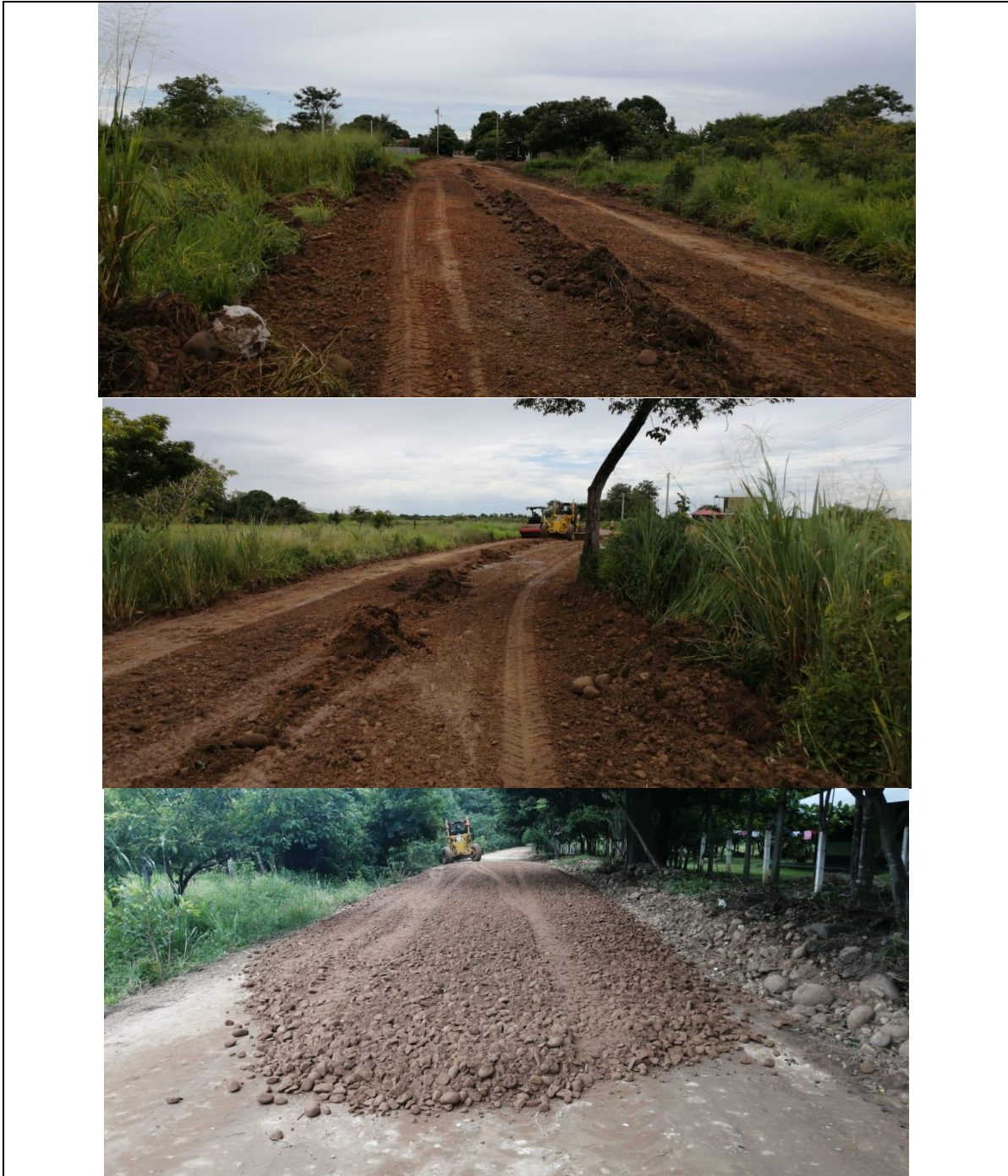
Vía Canalete km 5
