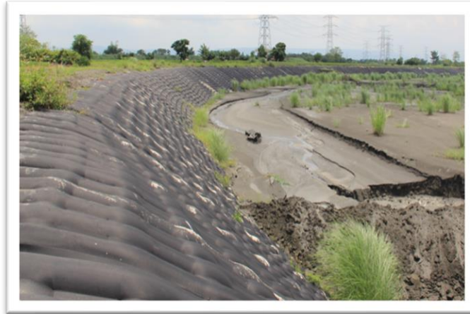
Imagen referencia Obra de Mitigación
